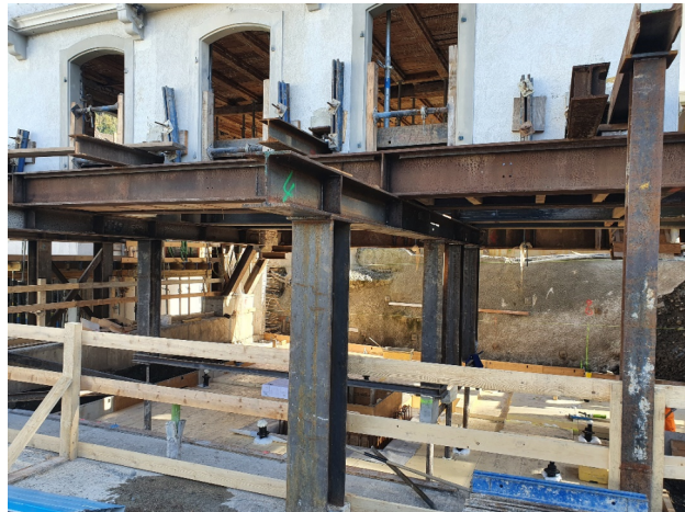
Stahlgerüst und Querversteifungen im bestehenden Gebäude
