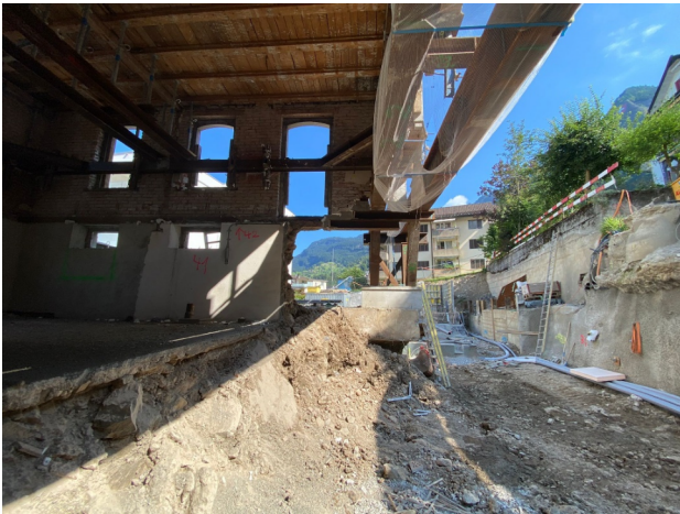
Unterfangung der östl. Fassade (Lagerung auf Pfahlwandscheibe)
