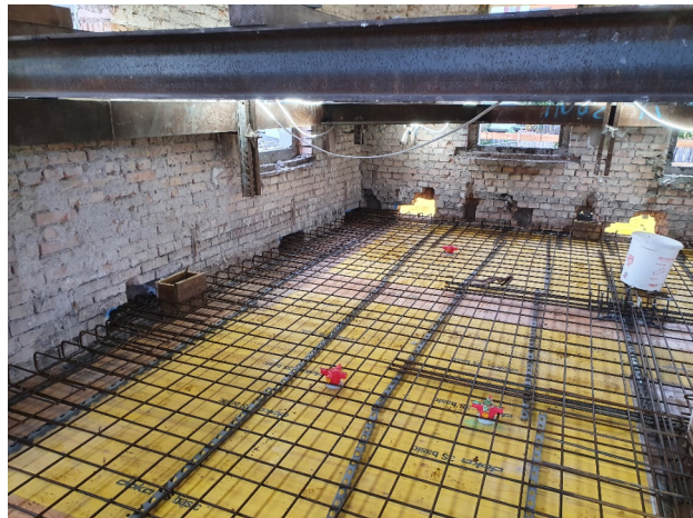
Schalung und Armierung der neuen Decke über dem Erdgeschoss
