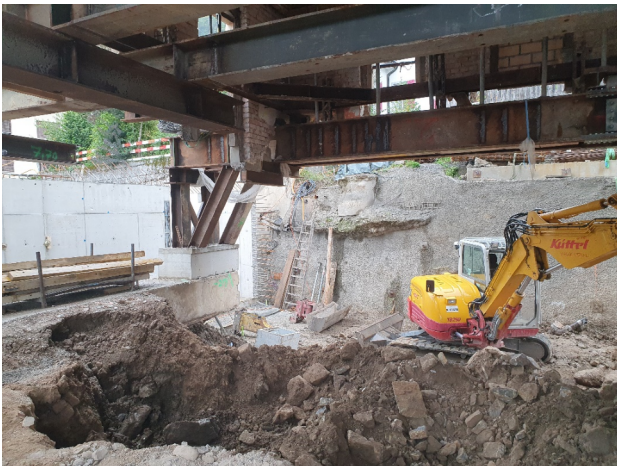
Aushub des neuen Kellergeschosses
