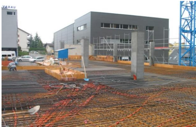
Decke über Obergeschoss mit Betonstützen und schlaffer Bewehrung
