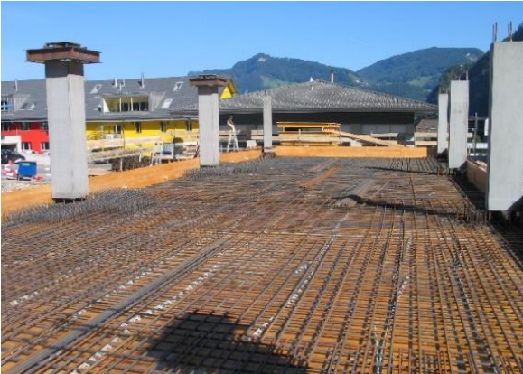
Zwischendecke über Erdgeschoss mit Betonstützen und Stahlpilzen
