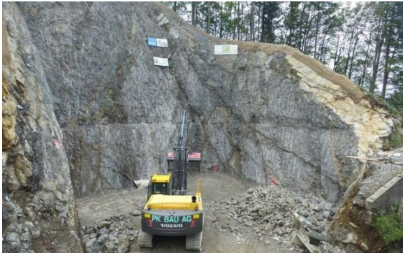
Felsaushub für das Reservoir
