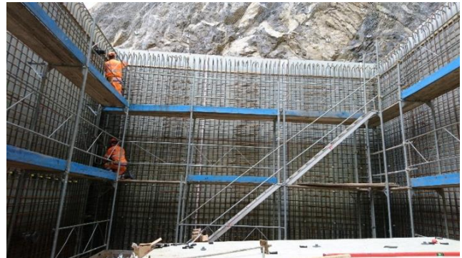
Stahlbeton / Bewehrung der Reservoirkammern
