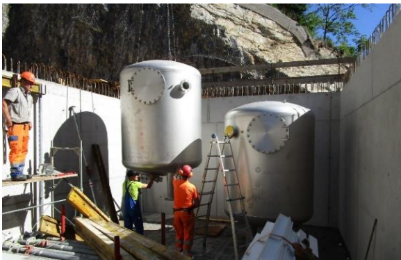
Einbau Aktivfilteranlagen
