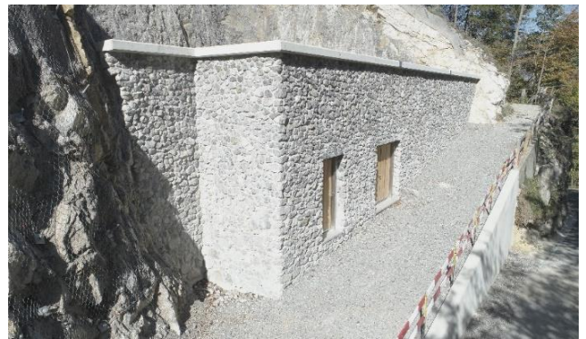
Steinfassade des Reservoirs / Eingangsbereich
