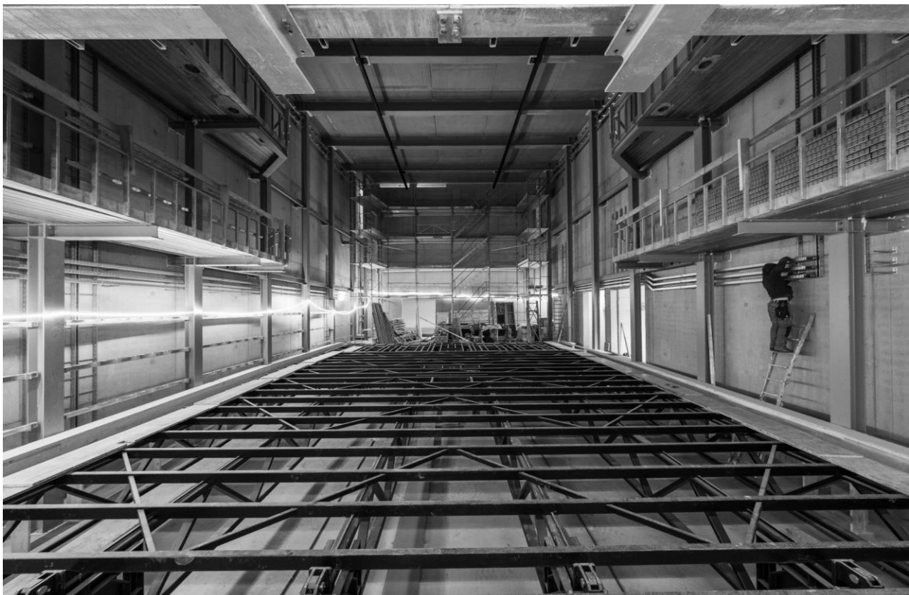
Innere Tragkonstruktion des Kammermusiksaals aus Stahl; Sichtbar sind auf beiden Seiten die 1. und 2. Galerie.
