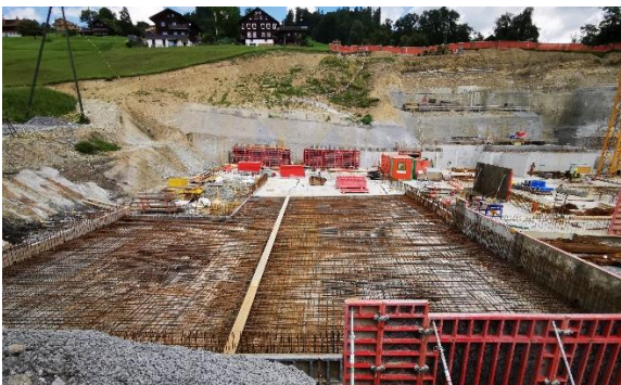
Arbeiten an der Bodenplatte
