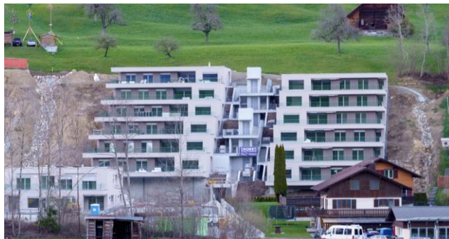
Ansicht auf die Terrassenhäuser nach Fertigstellung
