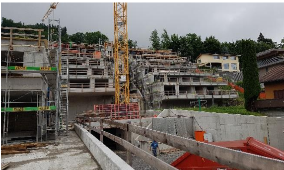
Ansicht auf den Rohbau der Terrassenhäuser
