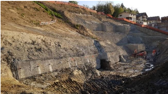
Ansicht der Baugrubensicherung
