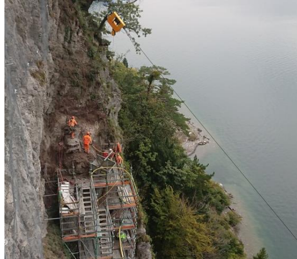
Schwerer Felsabbau mit einer Transportseilbahn
