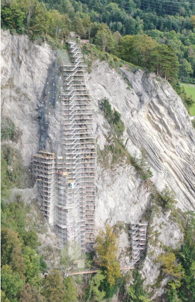
90m hohes Arbeitsgerüst zur Sicherung des Felspfeilers (7'000 m 3 )
