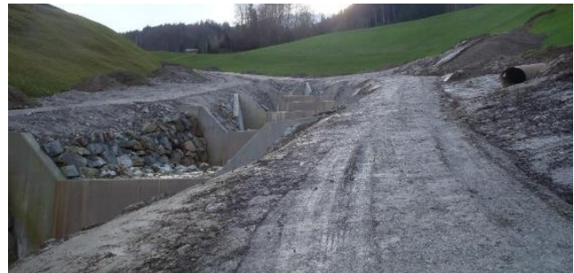
Bauetappe 1: Sperrentreppe neu
