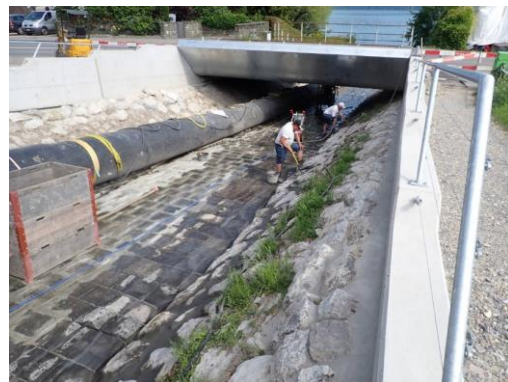
Bauetappe 5: Instandsetzung Bachschale, Einstauschürze
