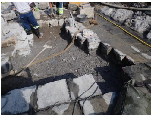
Bauetappe 5: Ersatz Sohlenbelegung "Moellons"
