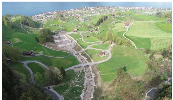
Bauetappe 2: Rückhalteräume mit Sperrentreppe
