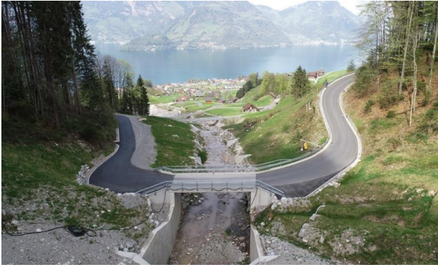
Bauetappe 3: Brücke mit Sperrentreppe
