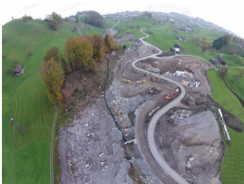
Bauetappe 2: Rückhalteräume Erdbau
