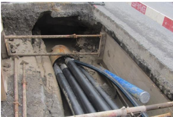
Unterstossung der Wasserleitung beim Mühlebach
