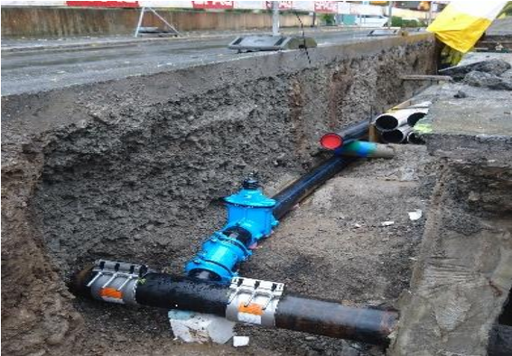
Neue Transportleitung mit Schieberkreuz
