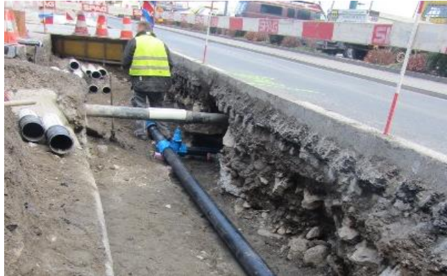
Neue Transportleitung Wasserversorgung
