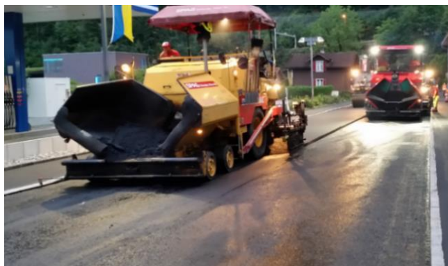
Nachteinsatz des Deckbelages
