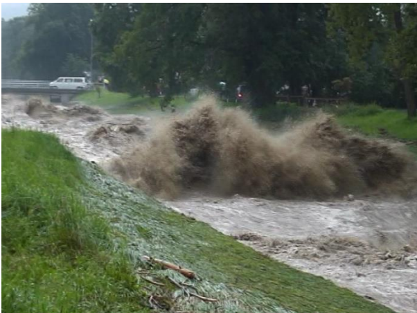
Hochwasserwelle im bestehenden Geschiebetriebkanal
