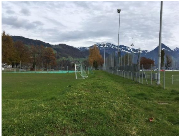
Mühlebach vor Massnahmen, eingedolt
