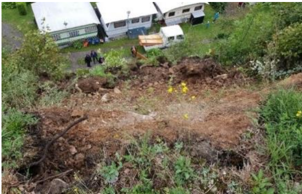
Hangrutsch Richtung Campingplatz
