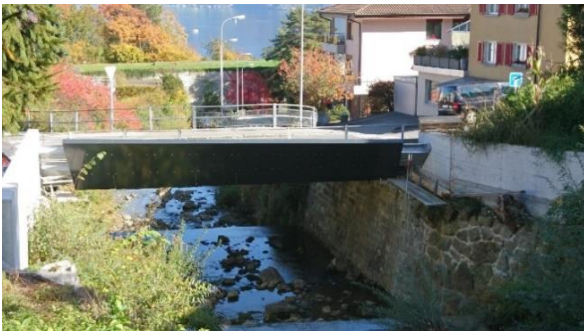
Althuserbrücke mit Einstauschürze
