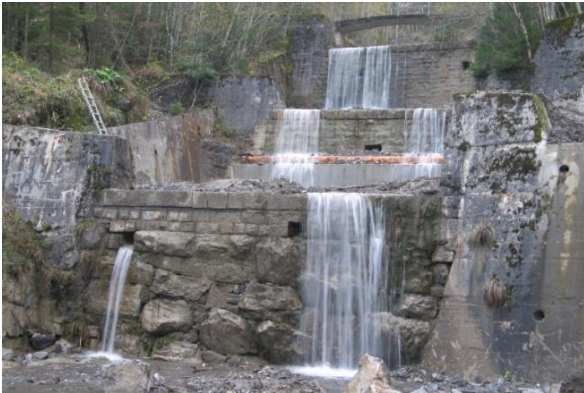
Instandgestellte Blocksteinsperren Gebiet Sören
